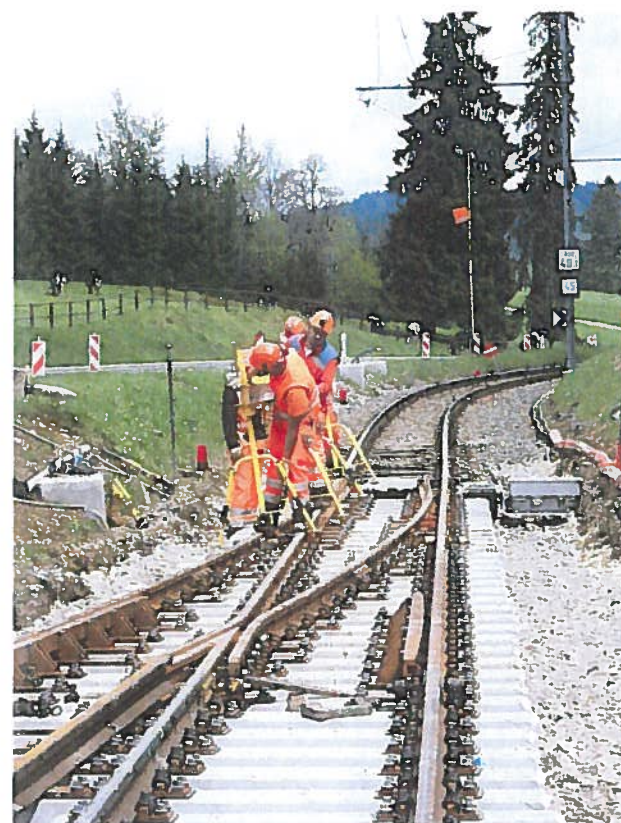
Des travaux promptement exécutés sur le chantier proche de la route principale H18 / H30 (© CSC Déchets SA)
